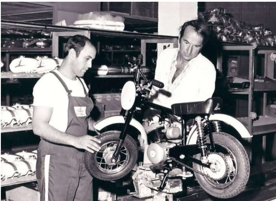
Foto 5. Het samenbouwen van een MMB-V1 in de fabriek van Italjet ca. 1969. (Bron: Italjet).
